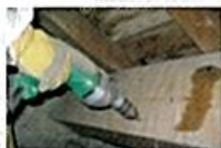
Perçage et injection
