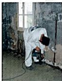
Injection dans les sols et murs
